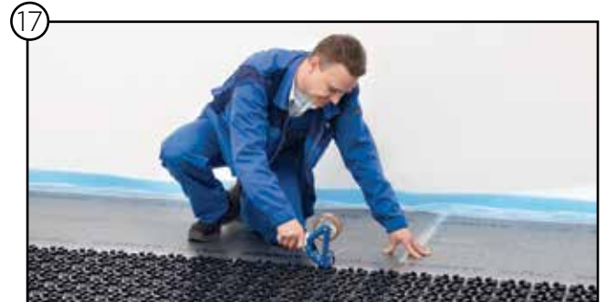
Abkleben der Stöße und Randdämmstreifen
