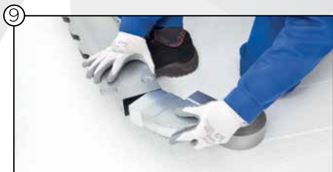
Montage Flachkanalbogen
