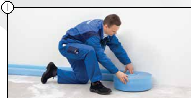
Randdämmstreifen montieren
