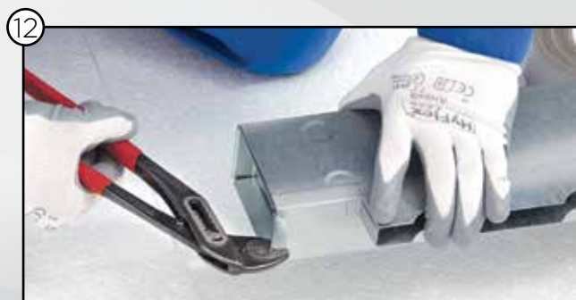
Sicherung Deckel durch Umlegung der Haltenasen
