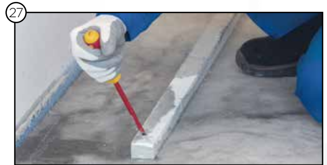
27 Entfernen des Rohbaumontageblocks
