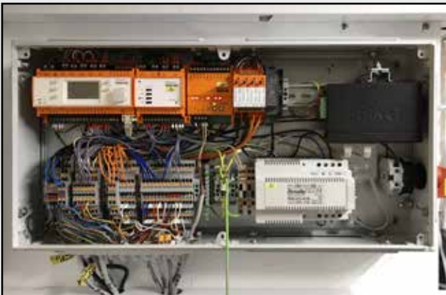
Regelung RLT-Gerät
