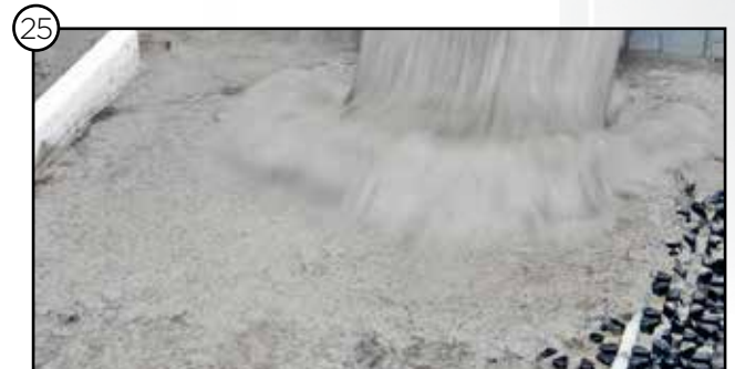
25 Einbringen des Estrichs
