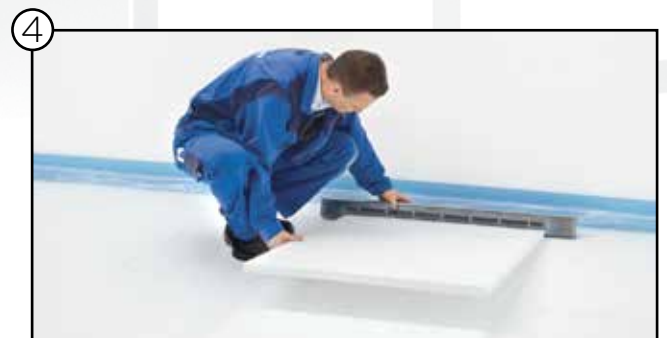
Distanzplatte zum AIRCONOMY® Systemmodul montieren
