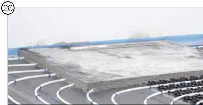
26 Rohbaumontageblock nach der Estricheinbringung
