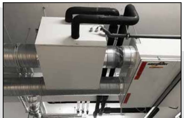
Deckengerät für Wohnungslüftung mit Kühlfunktion
