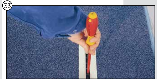
Schlitzschiene festziehen ... fertig!
