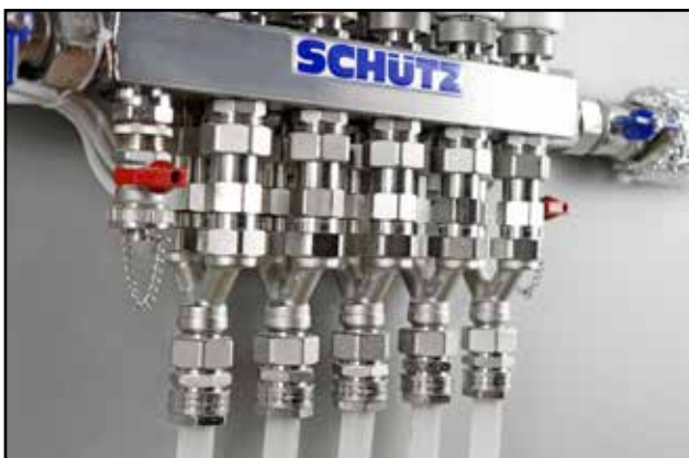
Heizkreisverteiler (4-Leiter-System)
