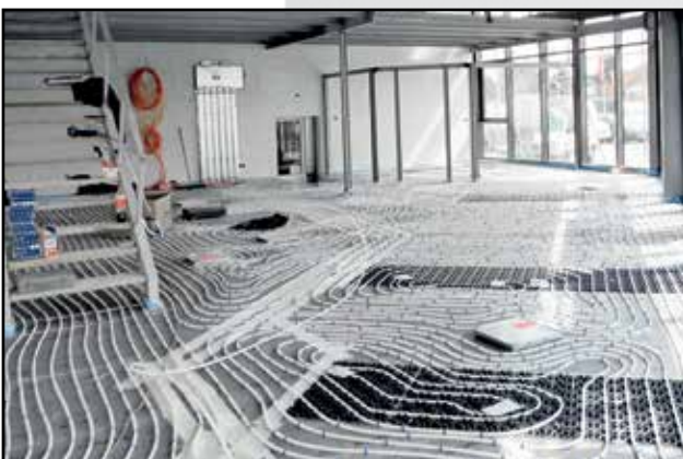
Verlegebeispiel vor der Estricheinbringung (Autohaus)
