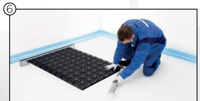
Verbindungselement montieren
