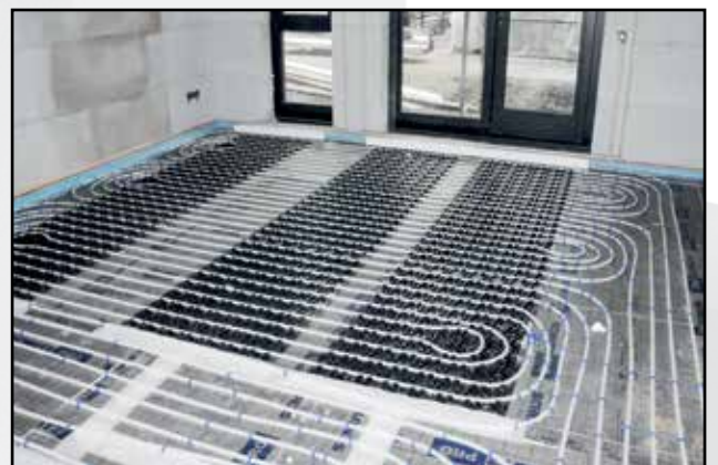
Verlegebeispiel vor der Estricheinbringung (Seniorenheim)
