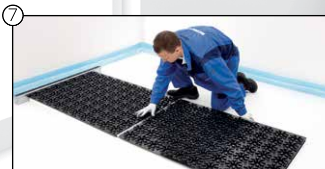
Zweites AIRCONOMY® Systemmodul montieren
