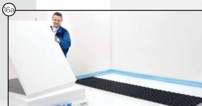
Auslegung der AIRCONOMY® faltplatte
