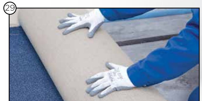
29 Verlegen des Bodenbelags
