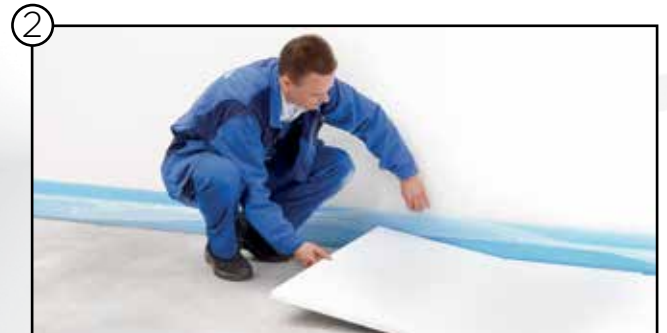
Trittschalldämmung auslegen
