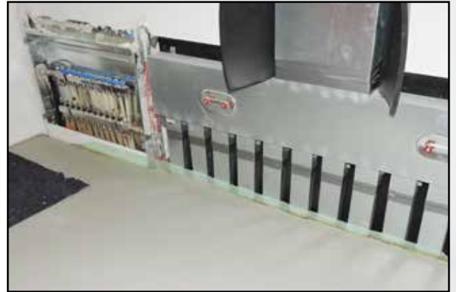
Heizkreisverteiler und Luftverteiler
