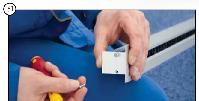
31 Schlitzauslassprofil montieren
