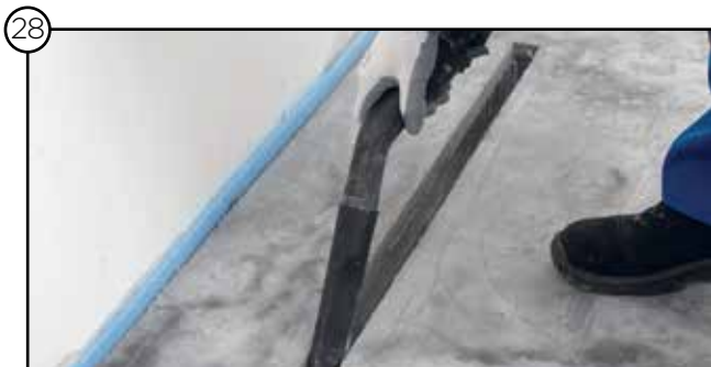
28 Reinigen des Ausblaskastens
