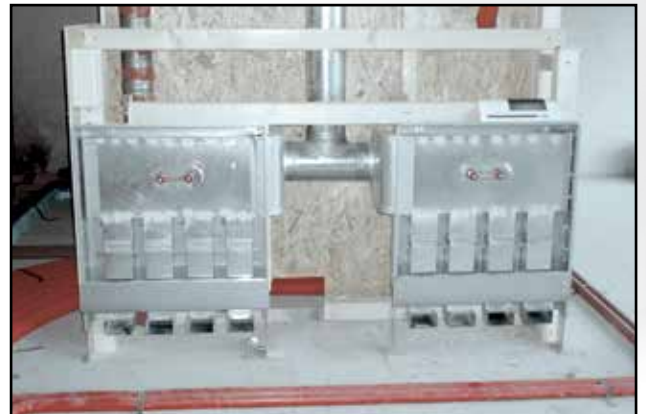
Luftverteiler
