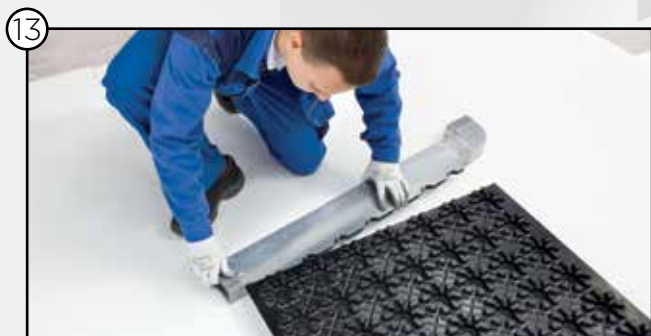
Montage des Einblaskastens am AIRCONOMY® Systemmodul
