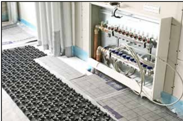
Heizkreisverteiler
