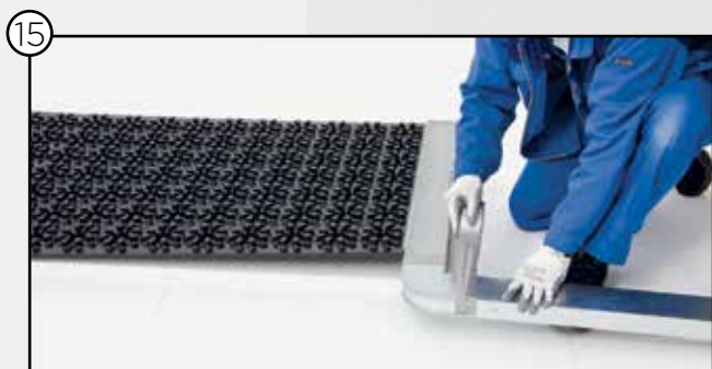
Montage und Abkleben der restlichen Flachkanäle
