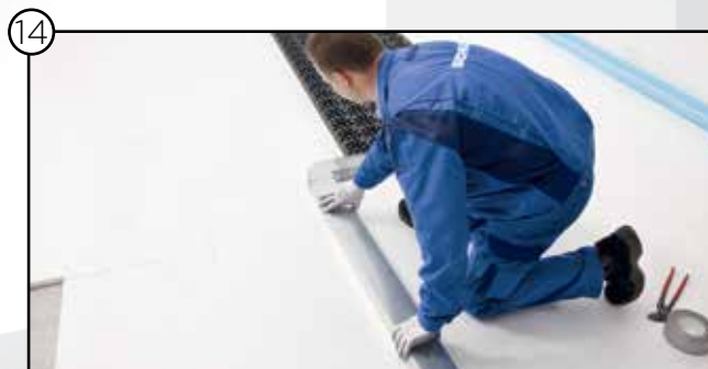
Montage und Abkleben der restlichen Flachkanäle
