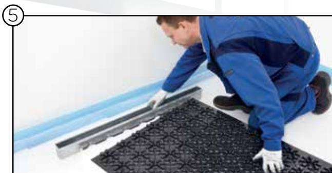
AIRCONOMY® Systemmodul in Ausblaskasten einschieben
