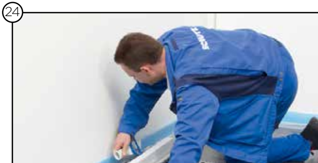
24 Vor der Estricheinbringung Rohbaumontageblock kontrollieren
