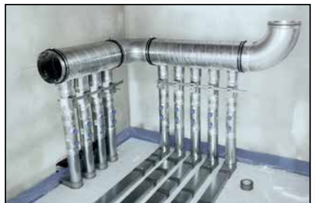
Luftverteiler
