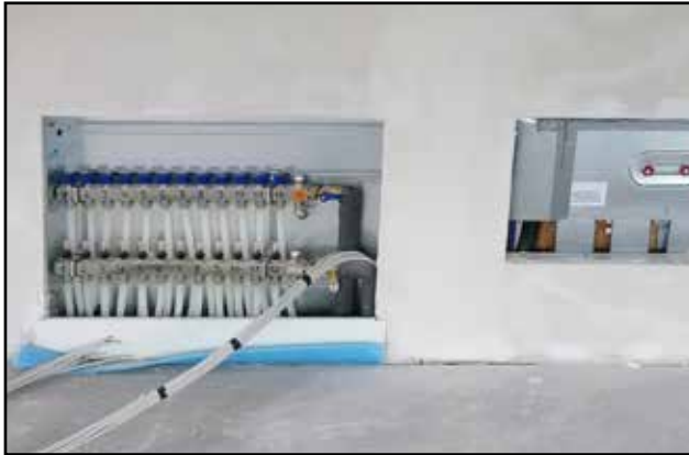
Heizkreisverteiler und Luftverteiler
