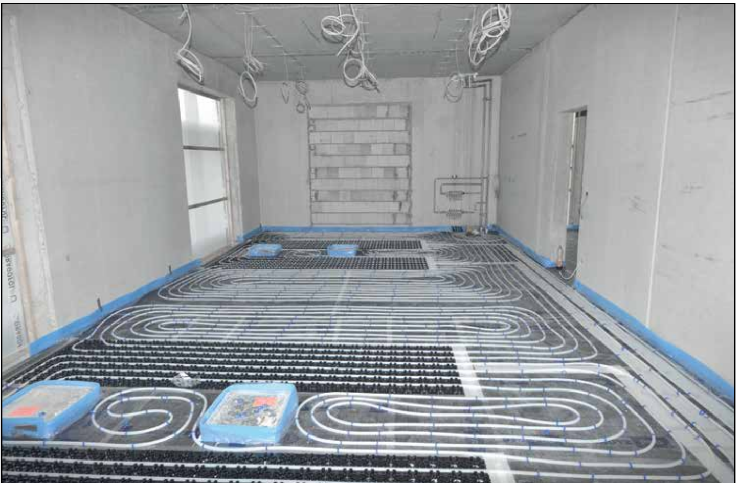
Verlegebeispiel vor der Estricheinbringung (Büro)
