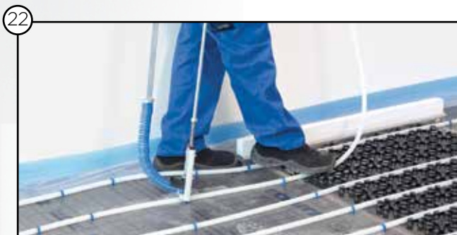
Befestigen des Heizrohrs
