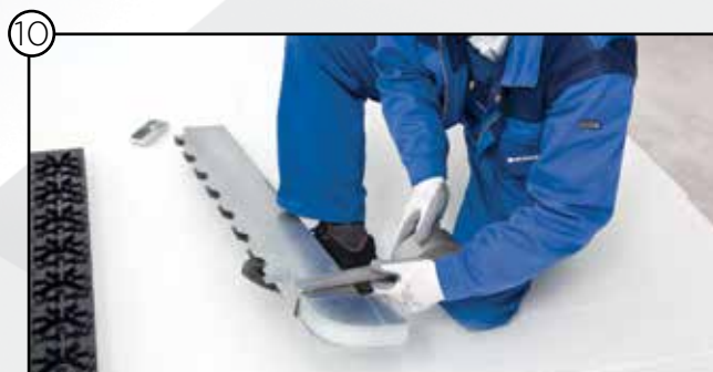
Abdichtung mit Bodenkanalklebeband (Gewebeeinlagen)
