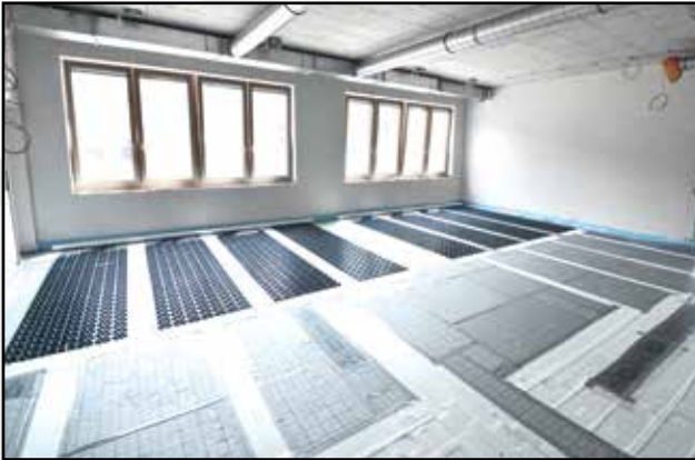
Bodenkonstruktion vor der Rohrverlegung
