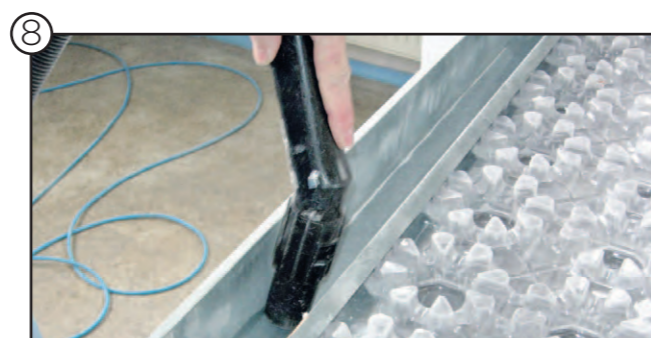
Reinigung des Luftauslasses mit einem Industriestaubsauger
