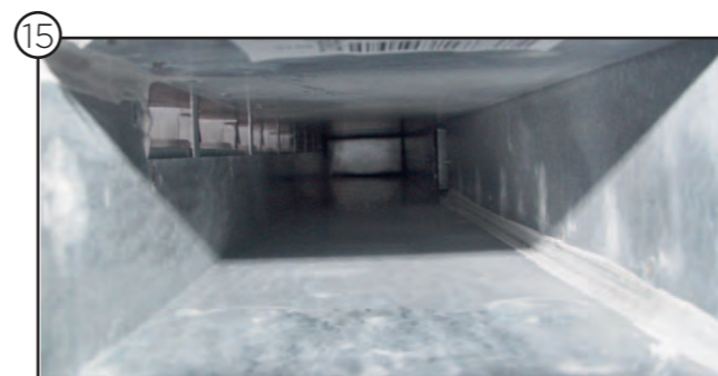
Kanalstrecke vor der Reinigung
