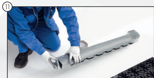
Verschließung der offenen Seite des Einblaskastens mit Deckel
