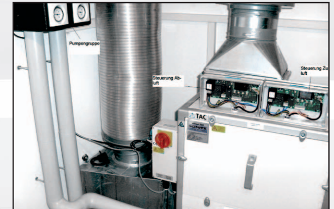
Regelung RLT-Gerät
