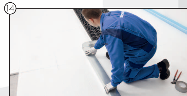
Montage und Abkleben der restlichen Flachkanäle
