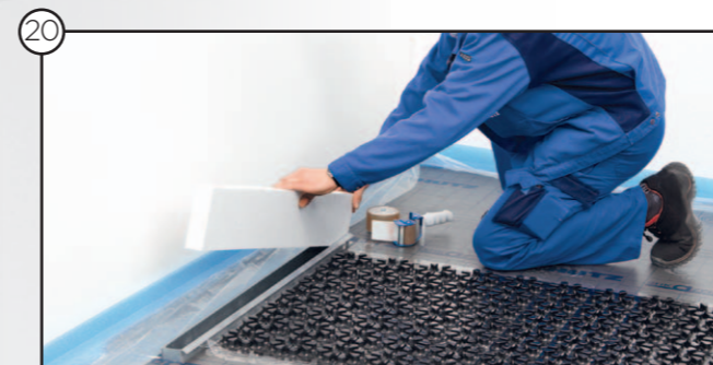
Einbau Rohbaumontageblock
