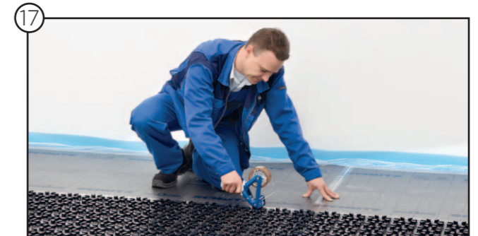
Abkleben der Stöße und Randdämmstreifen
