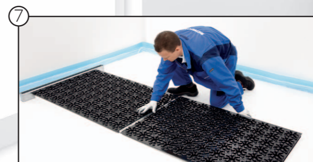
7 Zweites AIRCONOMY® Systemmodul montieren
