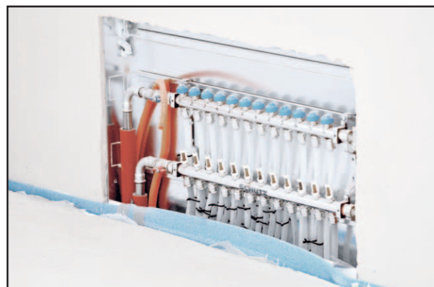
Heizkreisverteiler
