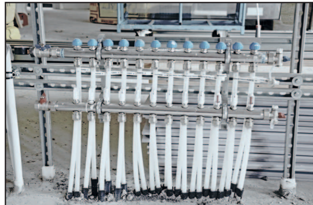
Heizkreisverteiler
