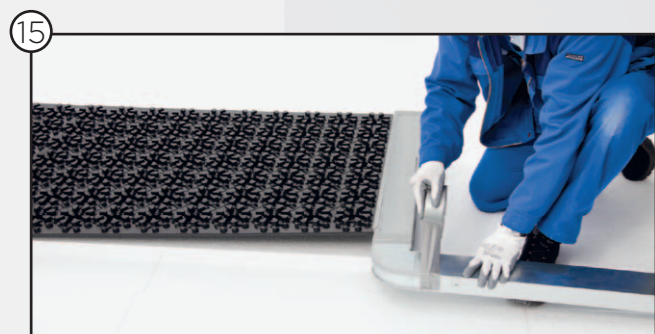
Montage und Abkleben der restlichen Flachkanäle
