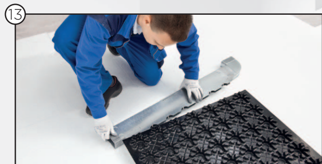
Montage des Einblaskastens am AIRCONOMY® Systemmodul
