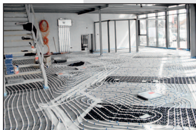
Verlegebeispiel vor der Estricheinbringung (Autohaus)
