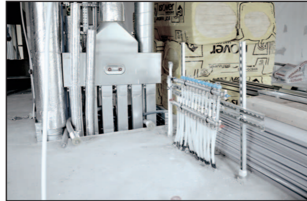
Heizkreisverteiler und Luftverteiler
