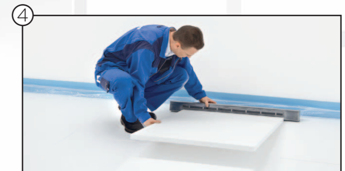
4 Distanzplatte zum AIRCONOMY® Systemmodul montieren
