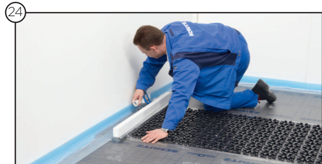
24 Vor der Estricheinbringung Rohbaumontageblock kontrollieren
