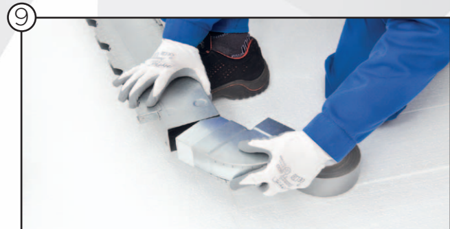
Montage Flachkanalbogen
