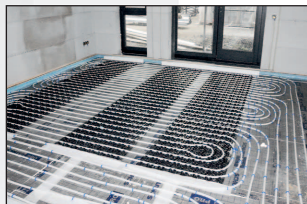
Verlegebeispiel vor der Estricheinbringung (Seniorenheim)
