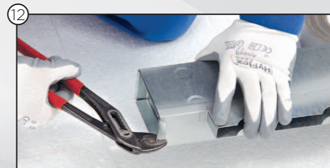
Sicherung Deckel durch Umlegung der Haltenasen
