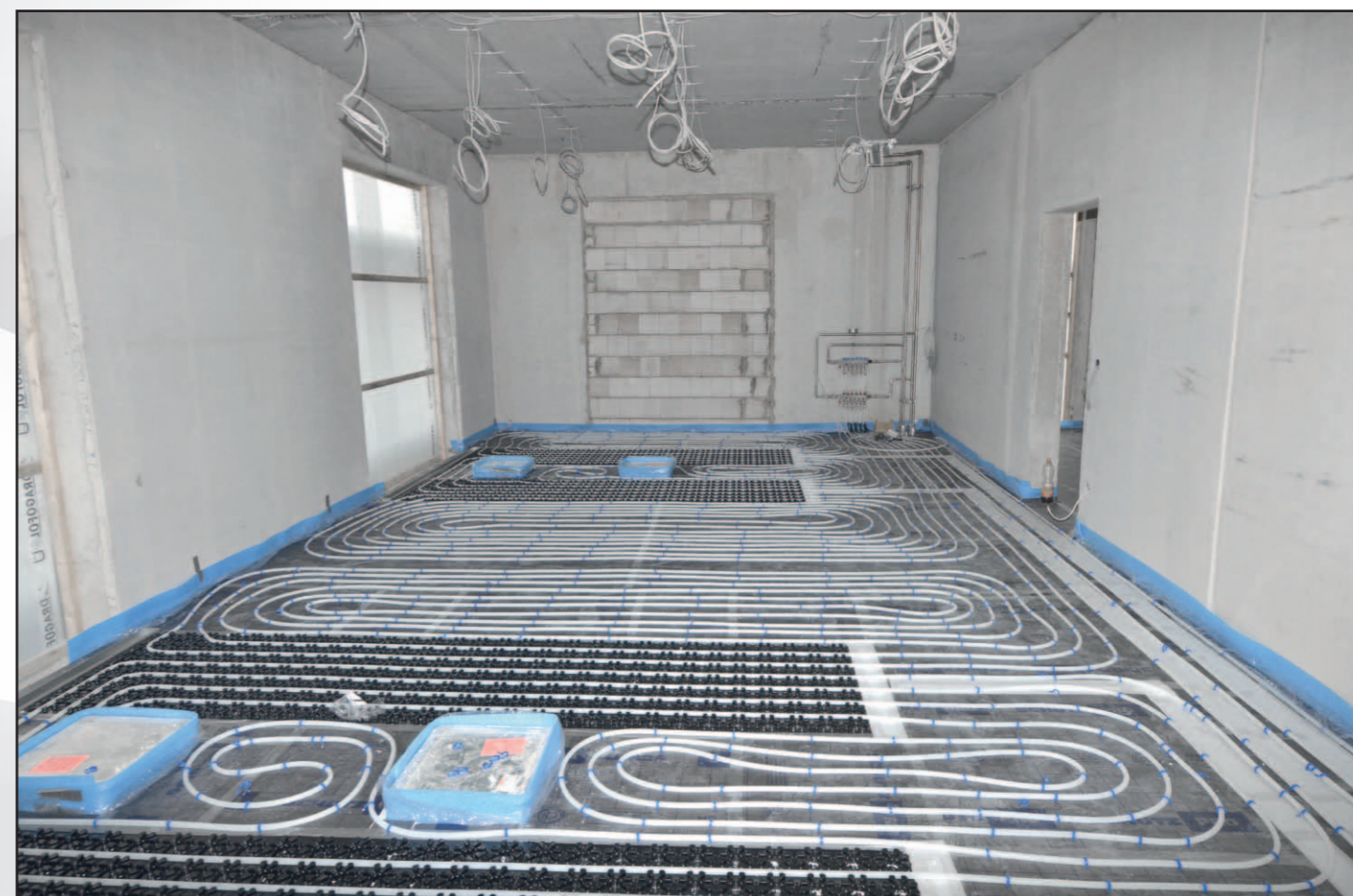
Verlegebeispiel vor der Estricheinbringung (Büro)
