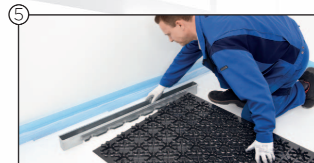
5 AIRCONOMY® Systemmodul in Ausblaskasten einschieben
