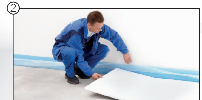
2 Trittschalldämmung auslegen
