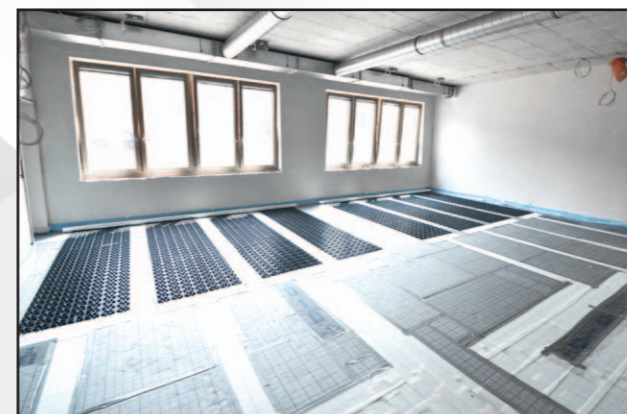
Bodenkonstruktion vor der Rohrverlegung
