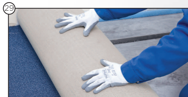
29 Verlegen des Bodenbelags
