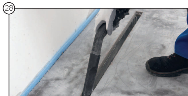
28 Reinigen des Ausblaskastens
