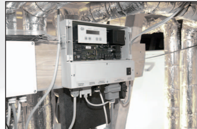
Regelung RLT-Gerät
