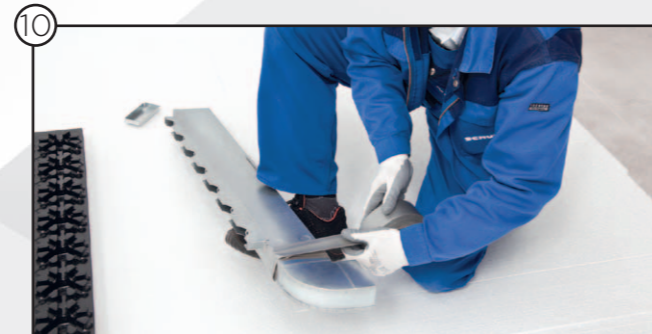
Abdichtung mit Bodenkanalklebeband (Gewebeeinlagen)
