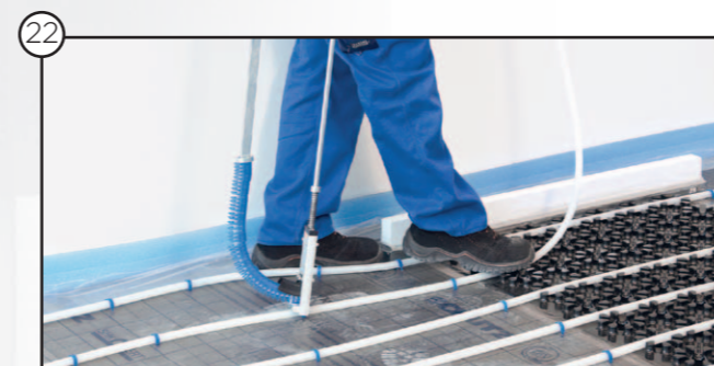
Befestigen des Heizrohrs
