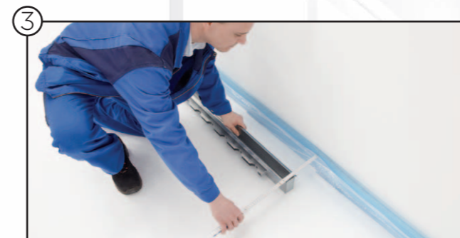
3 Ausblaskasten positionieren
