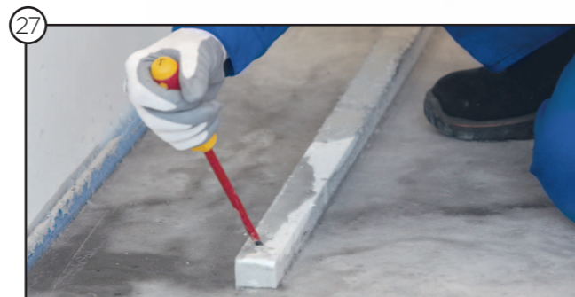
27 Entfernen des Rohbaumontageblocks
