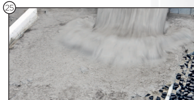
25 Einbringen des Estrichs
