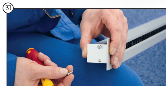
31 Schlitzauslassprofil montieren
