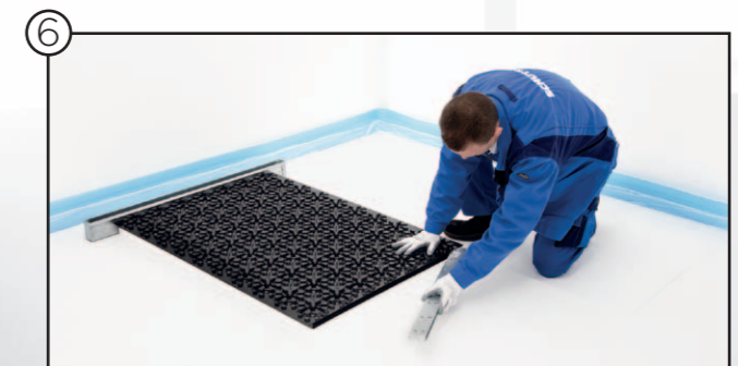
6 Verbindungselement montieren
