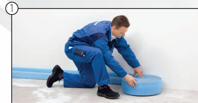
1 Randdämmstreifen montieren
