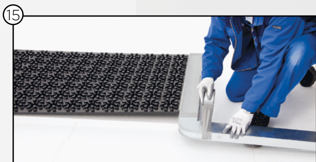
Montage und Abkleben der restlichen Flachkanäle
