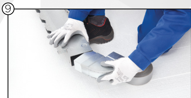
Montage Flachkanalbogen
