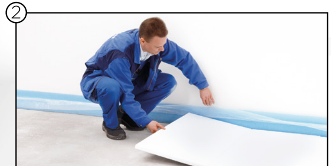
Trittschalldämmung auslegen
