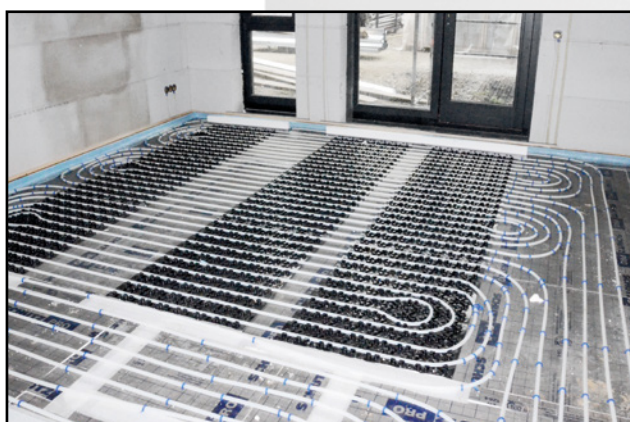
Verlegebeispiel vor der Estricheinbringung (Seniorenheim)
