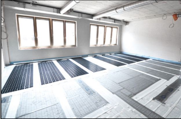
Bodenkonstruktion vor der Rohrverlegung
