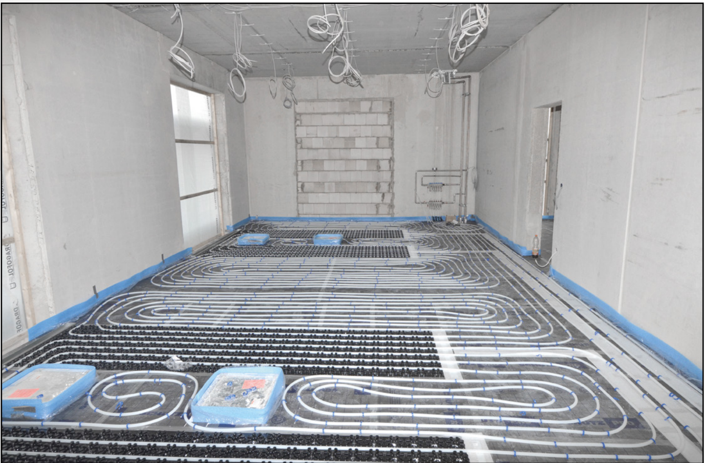
Verlegebeispiel vor der Estricheinbringung (Büro)
