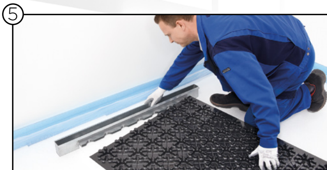
AIRCONOMY® Systemmodul in Ausblaskasten einschieben
