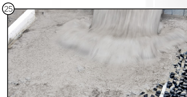
Einbringen des Estrichs
