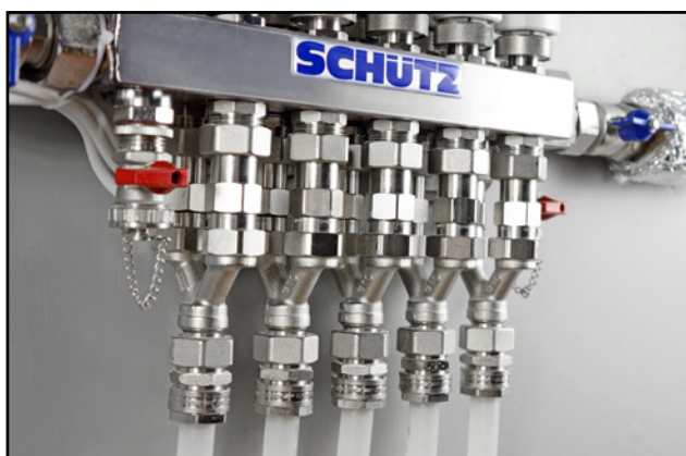
Heizkreisverteiler (4-Leiter-System)
