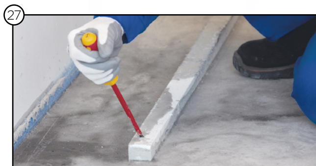
Entfernen des Rohbaumontageblocks
