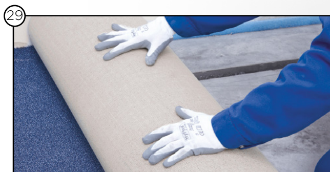
Verlegen des Bodenbelags
