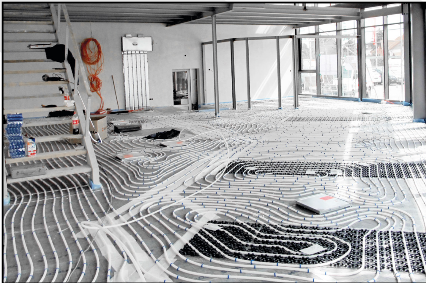
Verlegebeispiel vor der Estricheinbringung (Autohaus)
