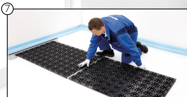
Zweites AIRCONOMY® Systemmodul montieren
