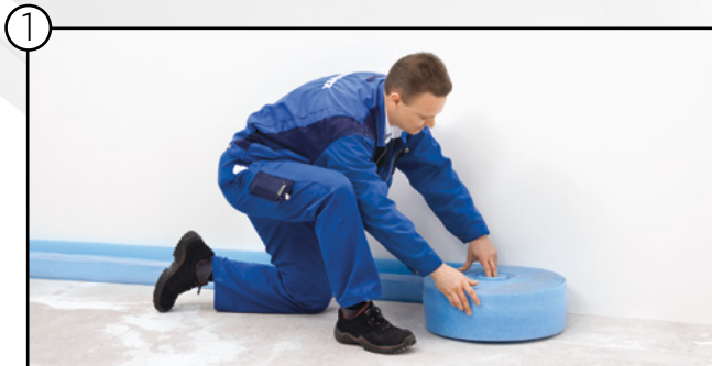
Randdämmstreifen montieren
