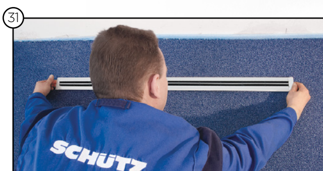
Profile einsetzen ... fertig!
