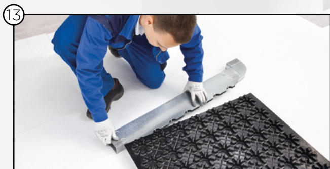
Montage des Einblaskastens am AIRCONOMY® Systemmodul
