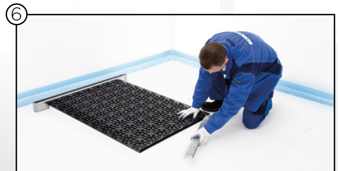
Verbindungselement montieren
