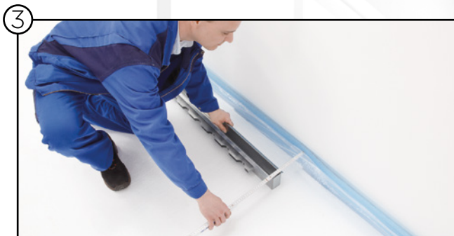
Ausblaskasten positionieren
