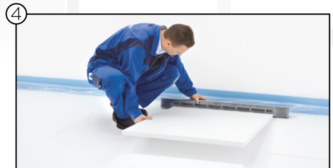
Distanzplatte zum AIRCONOMY® Systemmodul montieren
