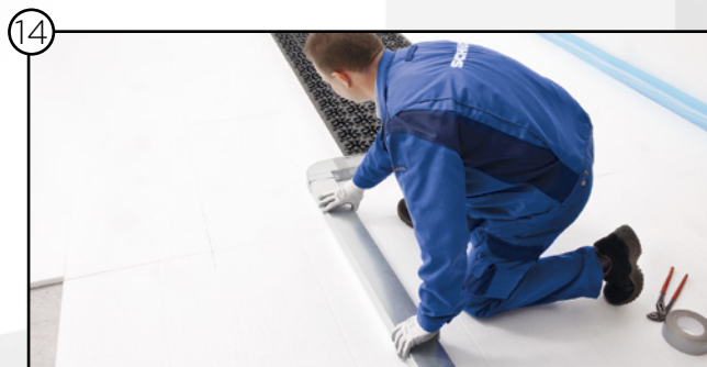
Montage und Abkleben der restlichen Flachkanäle
