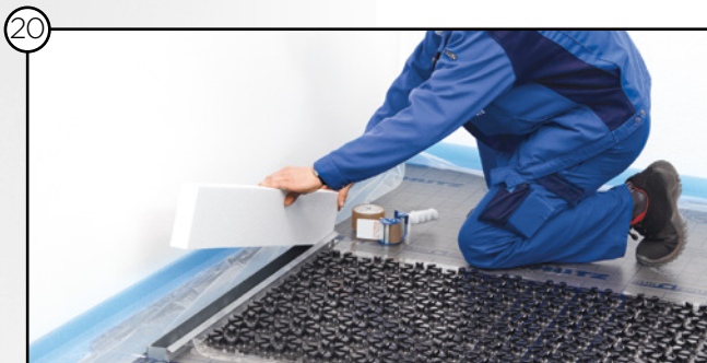
Einbau Rohbaumontageblock
