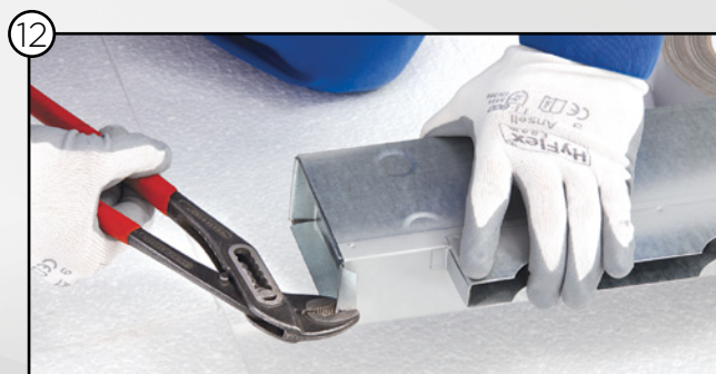
Sicherung Deckel durch Umlegung der Haltenasen
