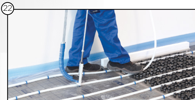
Befestigen des Heizrohrs
